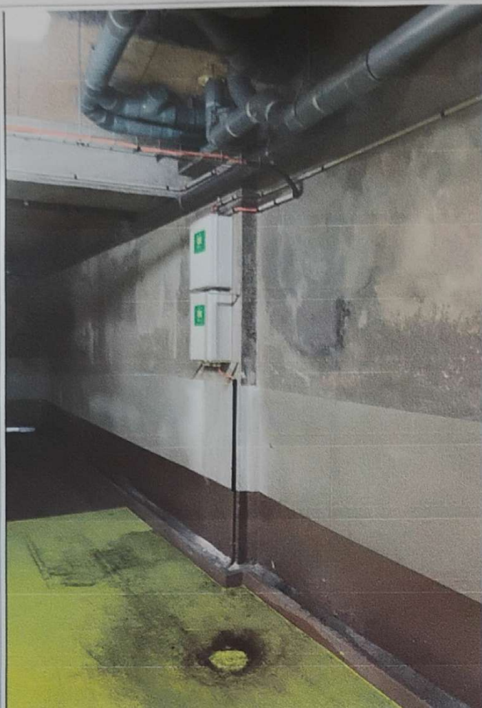
Conséquence du curage du 2 août 2024 : la canalisation a cédé.
