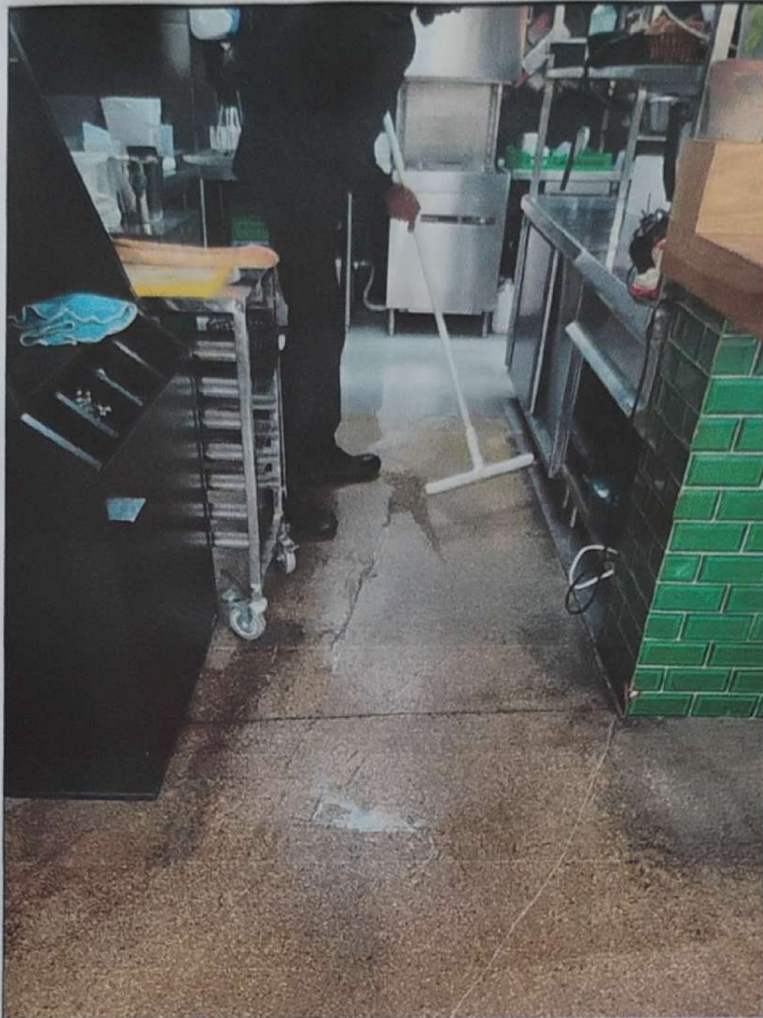
Suite à l'engorgement, l'eau remonte dans la cuisine par le syphon du sol (03/11/2024)
