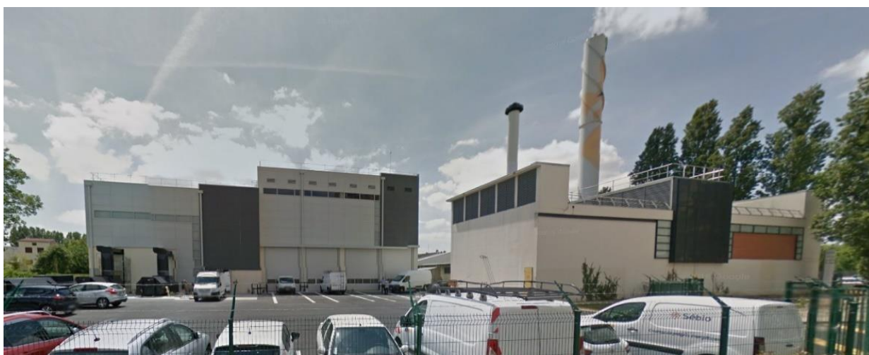
Figure 1. Chaufferie de Sevrans avec à gauche la chaufferie biomasse et à droite la centrale de cogénération. Source : Google StreetView.
