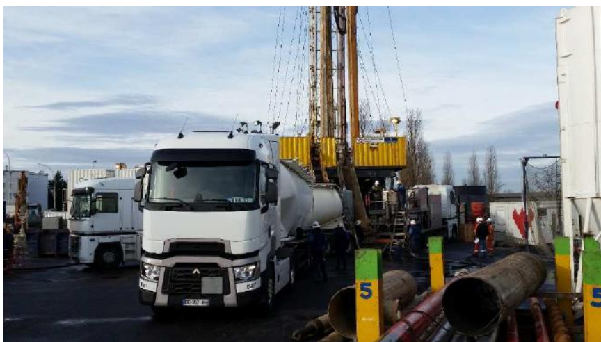
Figure 8 : Installation sur la plateforme à fin Décembre 2015. Source : BMES
