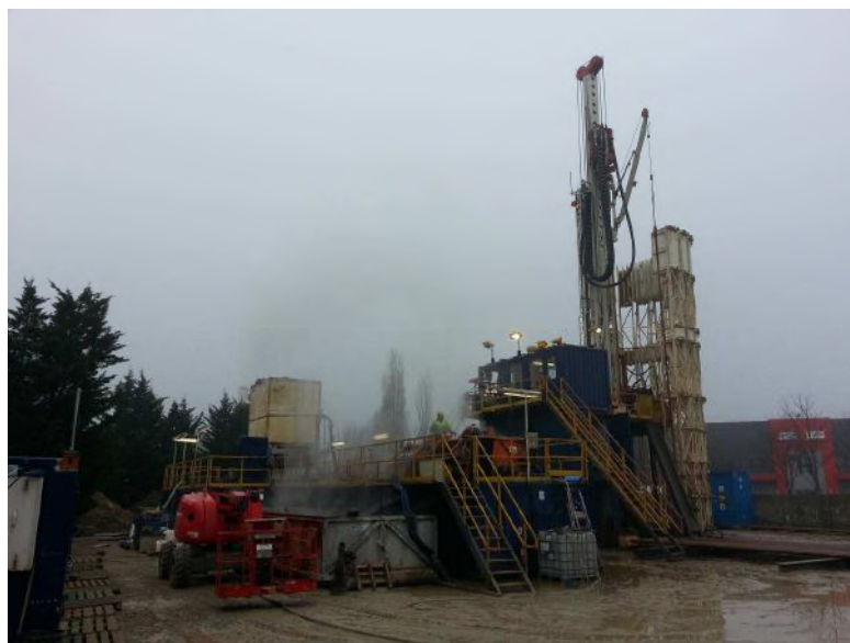
Figure 6 : Rig de scellement du doublet GBMN1/GBMN2 - Source BMES.
