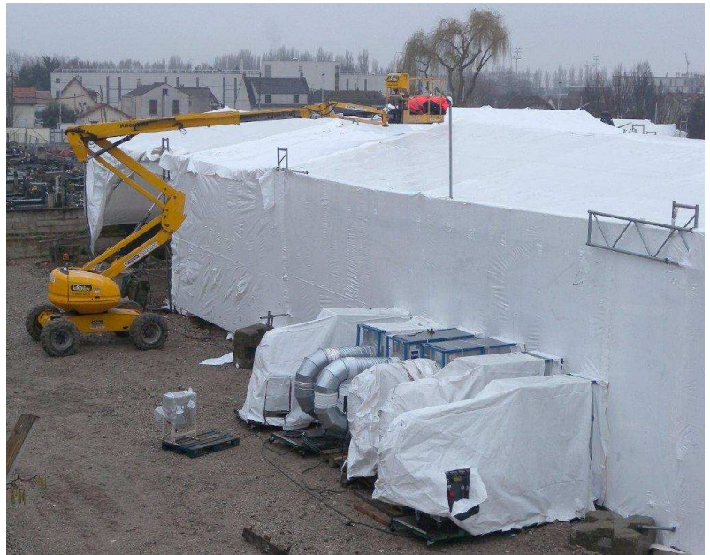
Photo de la mise en place du nouveau confinement le 10 janvier 2013
