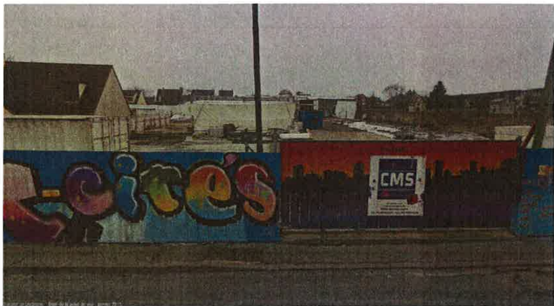
Accès au chantier pour les camions 107 rue de Mitry
