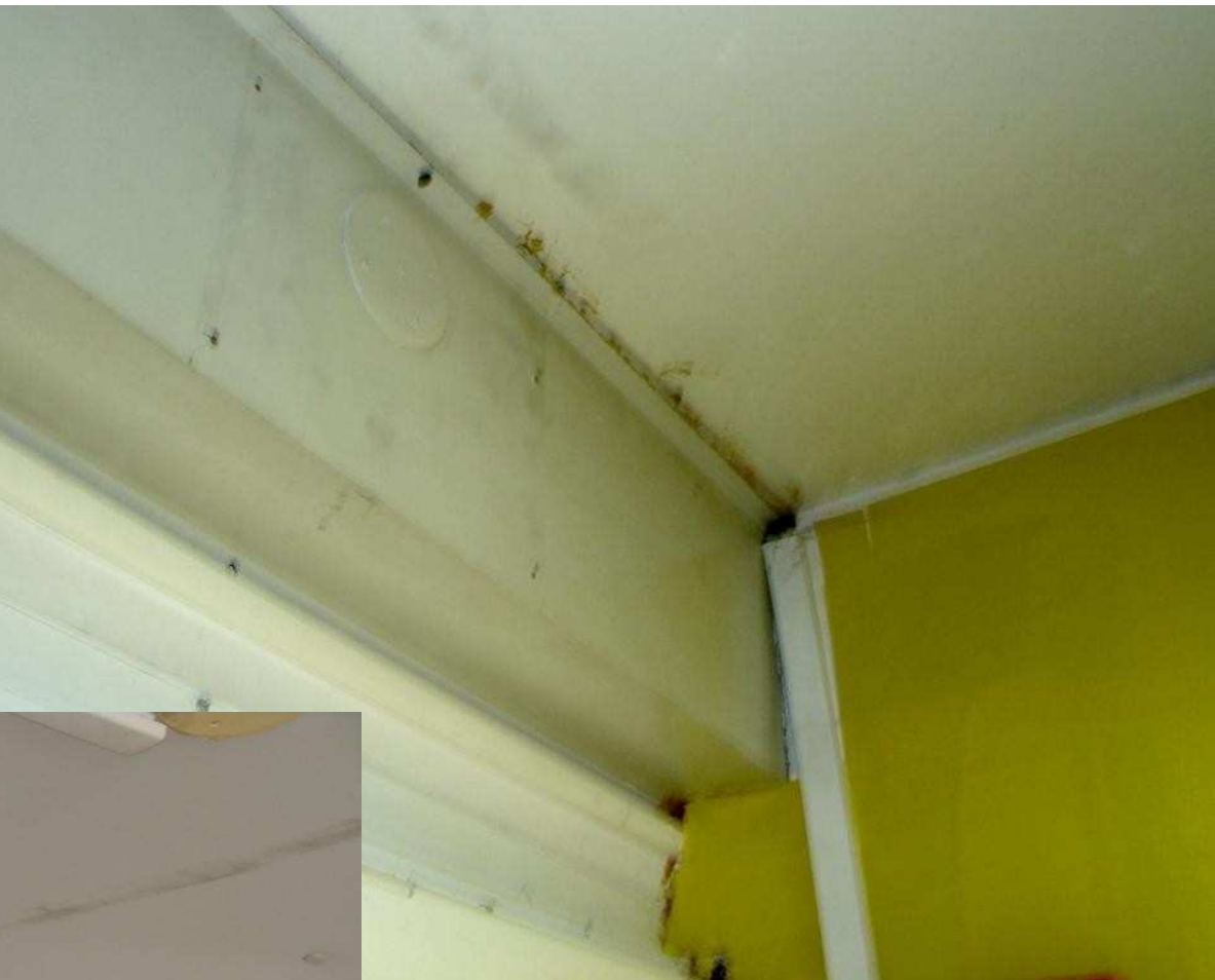
Pourriture et salpêtre sur le plafond de deux classes
