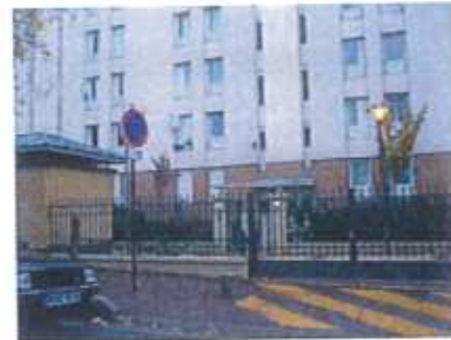
Travaux de résidentialisation
