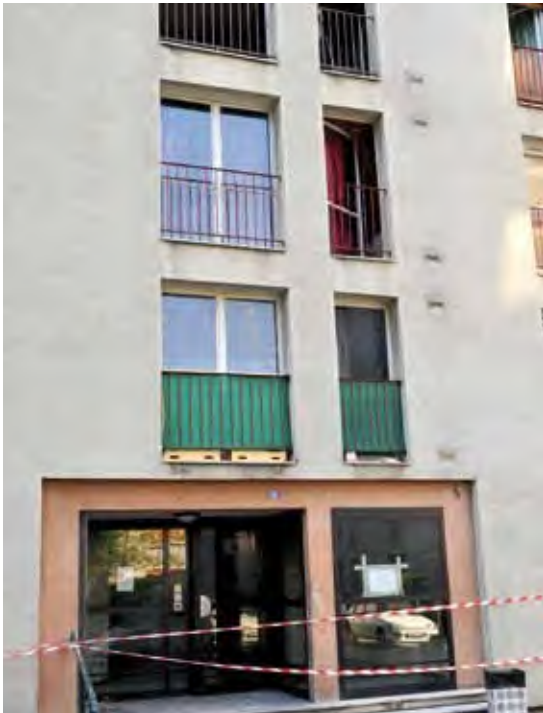
L'immeuble 12 rue des Aulnes.
