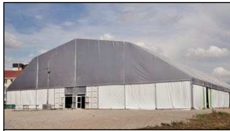
Le chapiteau installé sur la RN2 en face du Galion.
