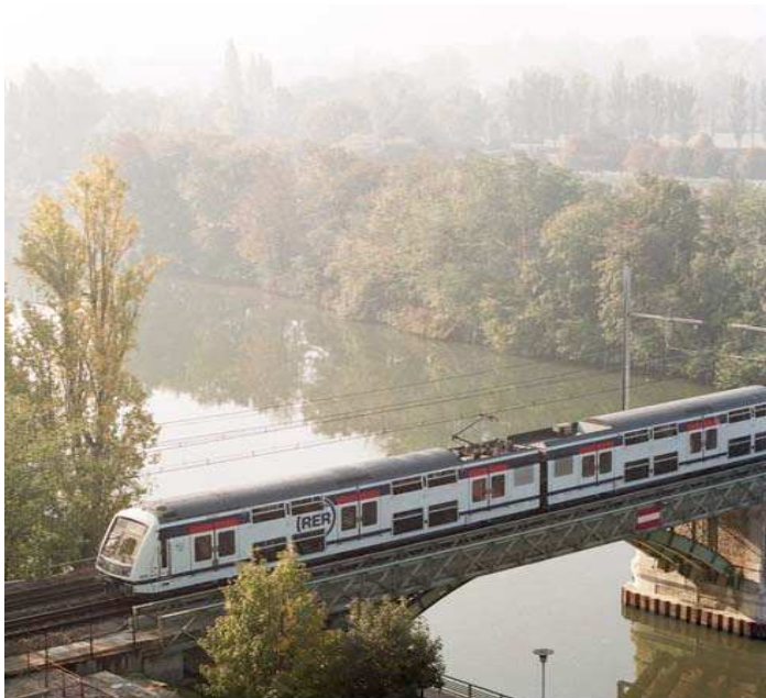
MI2N en circulation sur la ligne A
